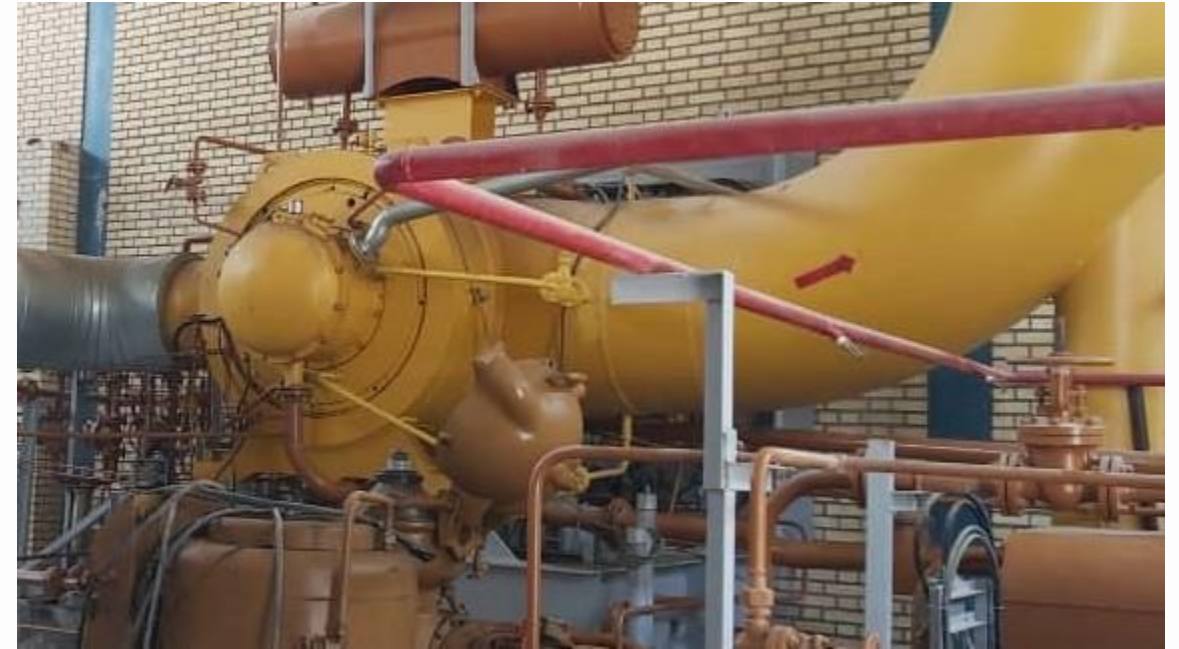
توربین نصب شده در نیروگاه شهید منتظری اصفهان با ظرفیت 6MW
